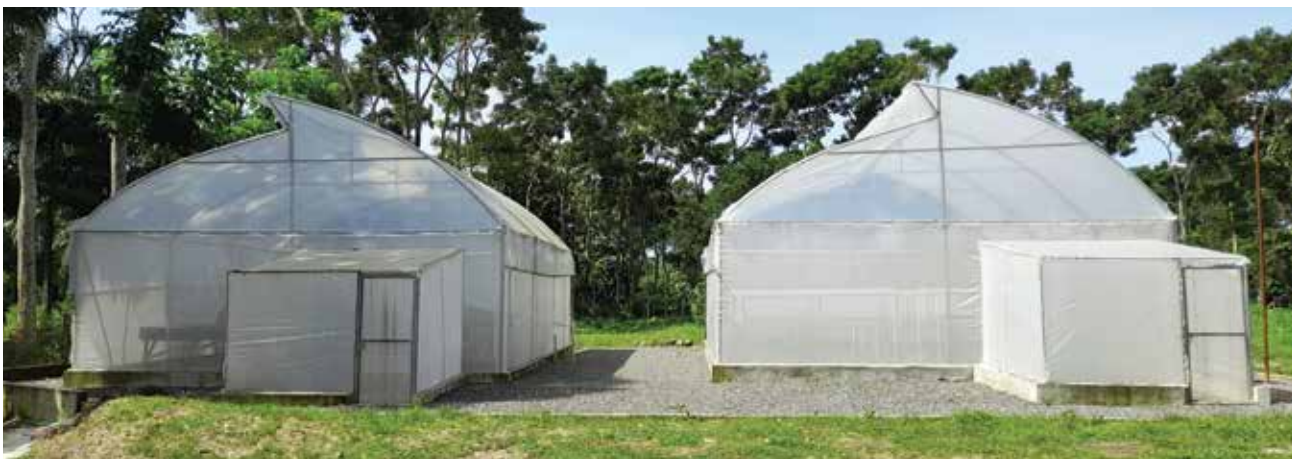
Invernaderos de 8 x 10 metros con casetas de ingreso.
