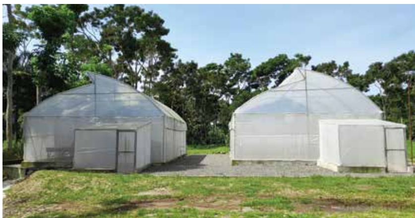
Edificación de jardín clonal y jardín de enraizamiento.
