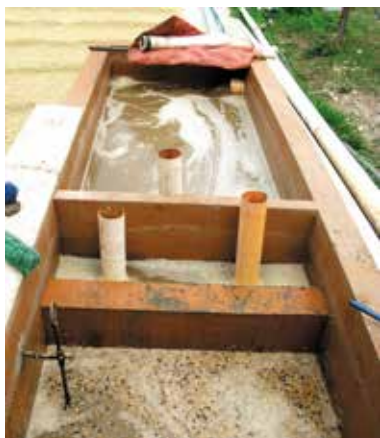
Tanque de recirculación de aguas
