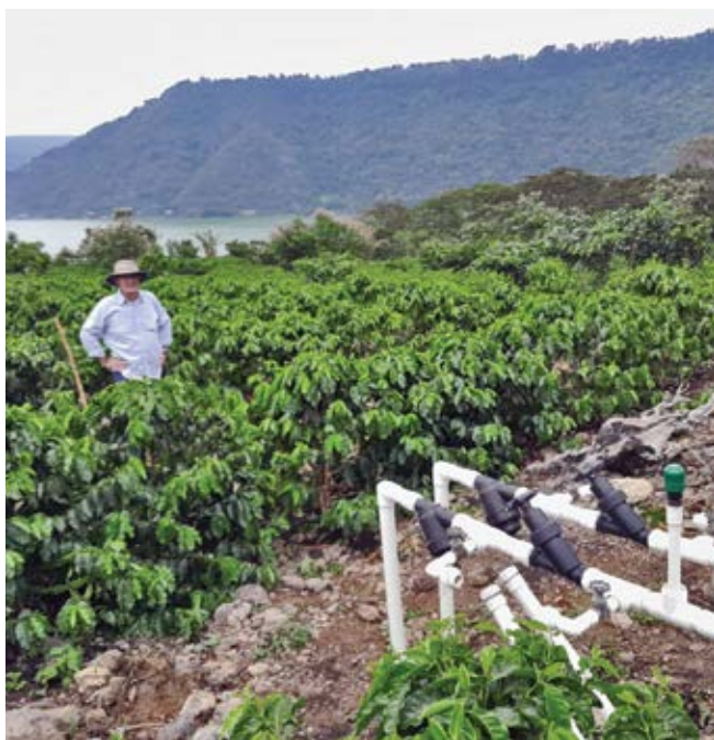
Reacondicionamiento de módulos de riego en unidad productiva San Gerardo, Amatitlán, Guatemala.
