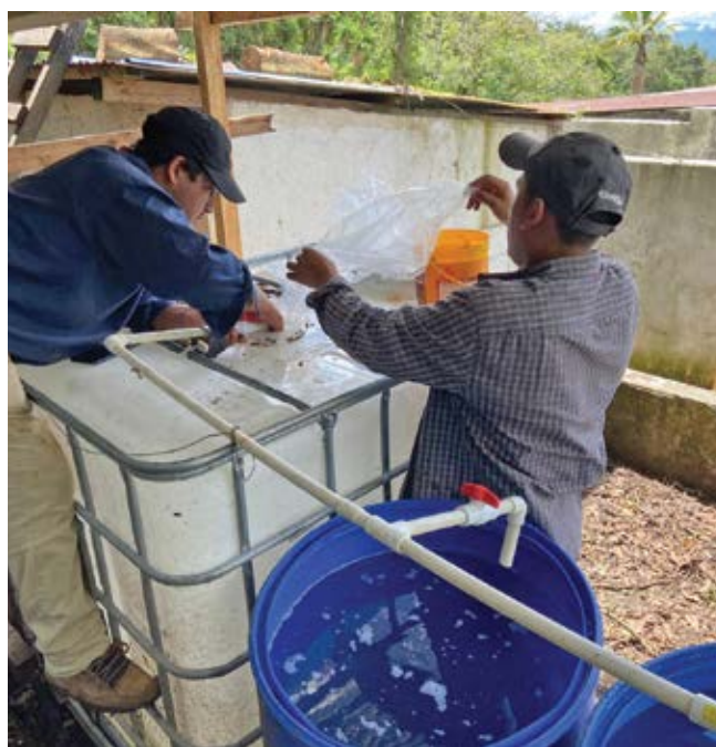
Instalación de sistema de riego y fertirriego en Unidad productiva el Valentón, Villa Canales Guatemala.
